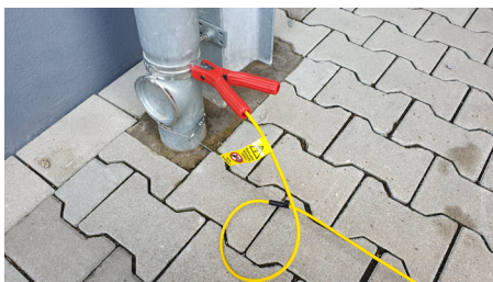
Erdung am Fallrohr
